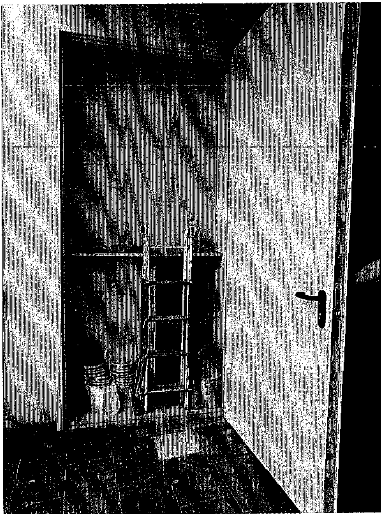
VOLUME TECNICO VICINO L'ASCENSORE
